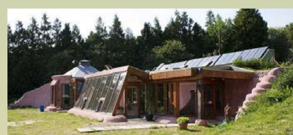
Exemple d'habitation construite sur les principes bioclimatique - © Dominic Alves CC by 2.0
