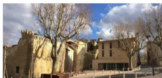
Îlot des Escourts : résidence intergénérationnelle 34 logements PLS – opérateur Nouveau Logis Provençal Mise en valeur des remparts, place et rue: travaux S.P.L.A.
