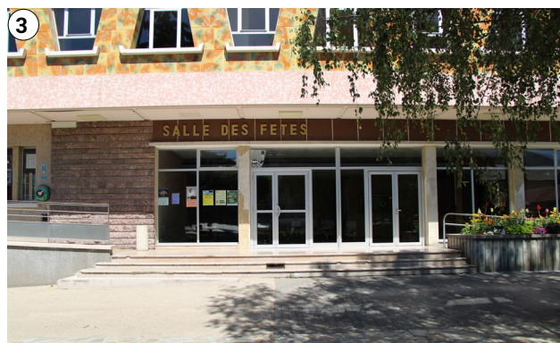
L'entrée de salle des fêtes et sa rampe PMR
