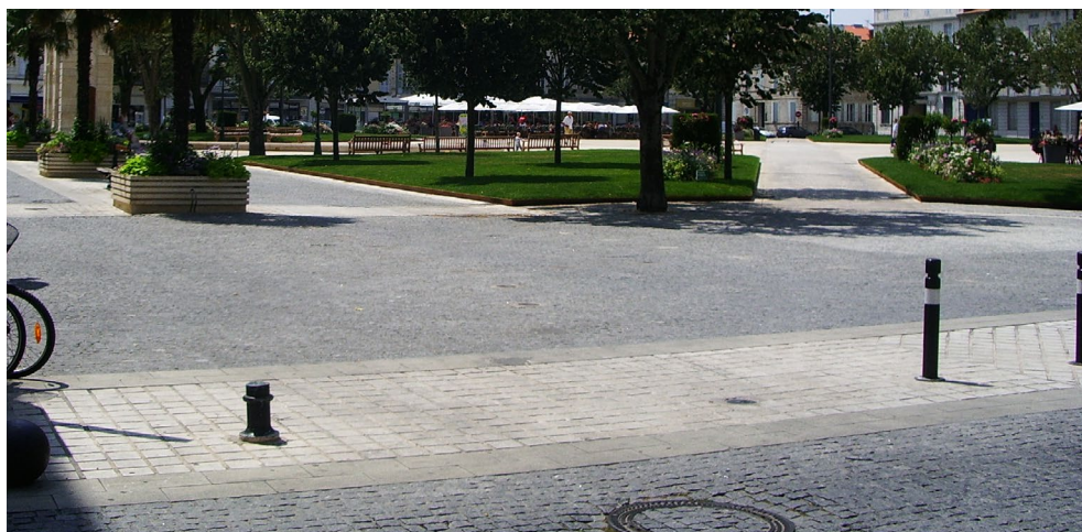
Des revêtements en pavés qui matérialisent les traversées et modifient la perception des conducteurs. Place Colbert à Rochefort par Bruno Coussy
