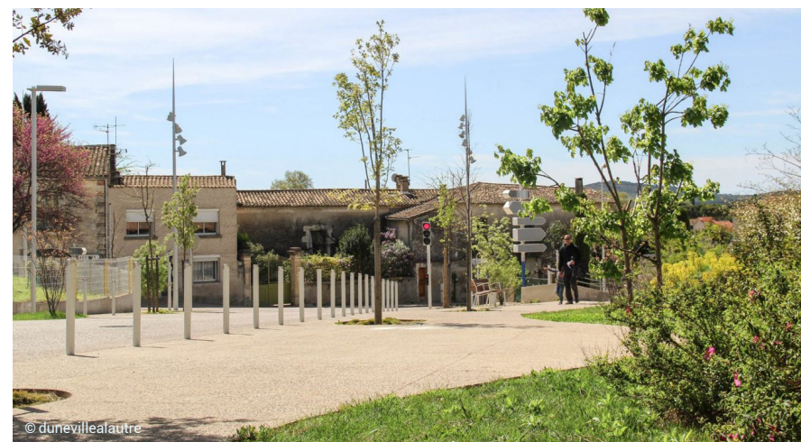
Aménagement de trottoirs élargis grâce à la suppression du stationnement - Saint-Jean-de-Vedas
