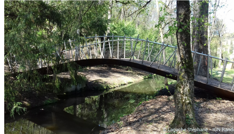
Passerelle piétonne au dessus de la Luyne à Gardanne
