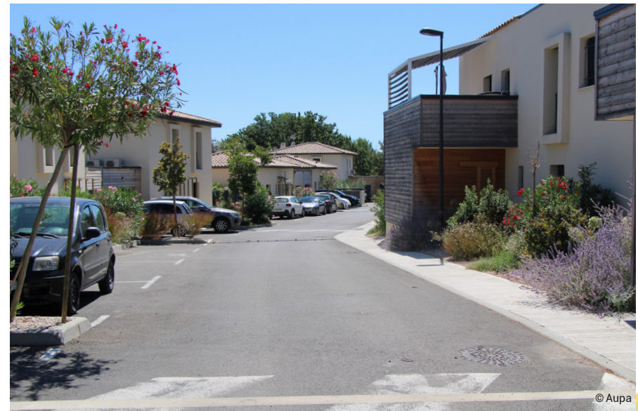
Voie de desserte interne - Saint-Cannat
