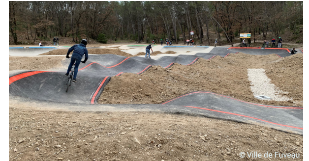
Intégration d'équipement sportif de plein air en zone naturelle - Fuveau centre
